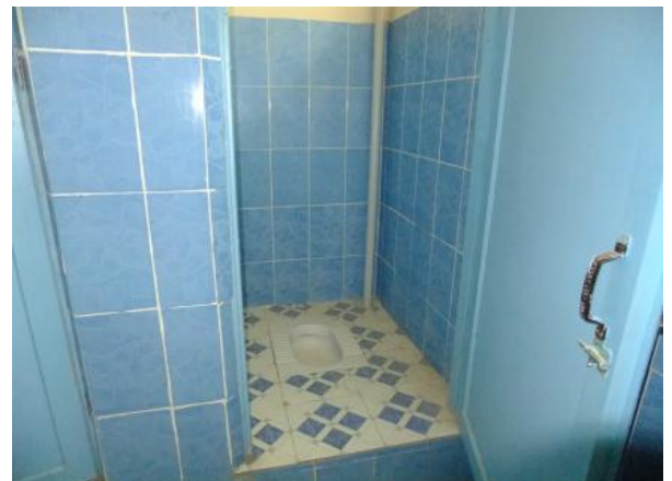
改修された学校トイレ。清潔なトイレが整備されたことにより、学校の衛生環境が大幅に向上しました。
